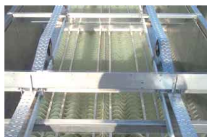
Pacco lamellare e convogliatore dei surnatanti
