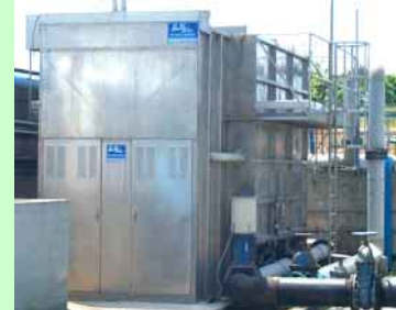
L'impianto di Depurazione di Seravezza dove è installato un Flottatore Lamellare con capacità di trattamento pari a 250.000 \text{ l/h} ,
